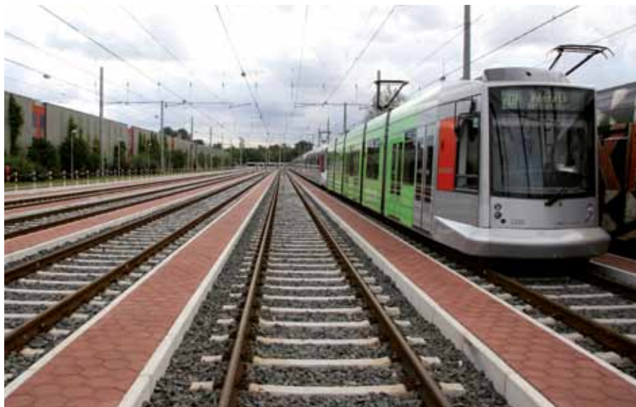
Abstellgleise in Lierenfeld
