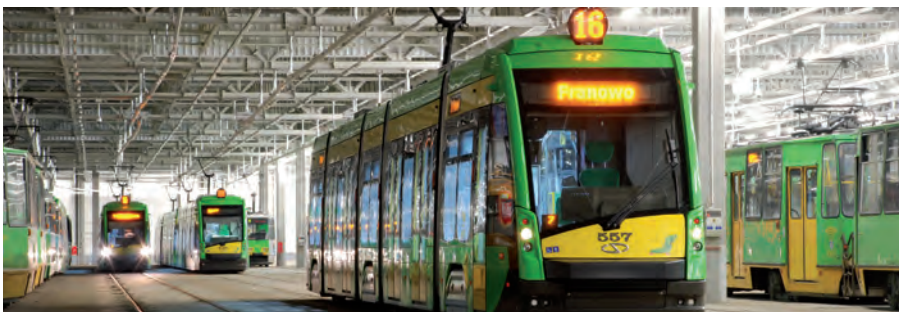
Das neue Straßenbahndepot der MPK.
